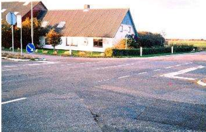
HEGNHOLT's hovedbygning i 2010.
